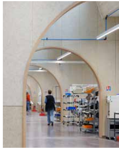
· Ci-dessus : Maroquinerie de Louviers - Hermès (2023), Lina Ghotmeh, architecte, structure bois et 510 000 briques fabriquées à 70 kilomètres du site par la briqueterie Lagrive, Calvados · © Iwan Baan
